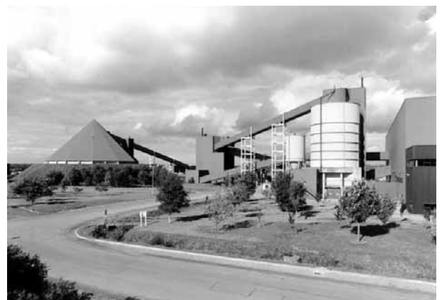
Photo 2. Installations de surface à Navan (Remerciements à Boliden Tara Mines Limited).
