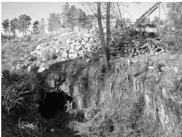
Photo 2. Chantier d'exploration en surface (cliché Paulo Ferraz).
