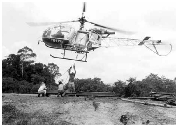
Photo 5. Hélicoptage de matériel de sondage au nord de Bélinga en 1980 (cliché Gérard Delorme).
