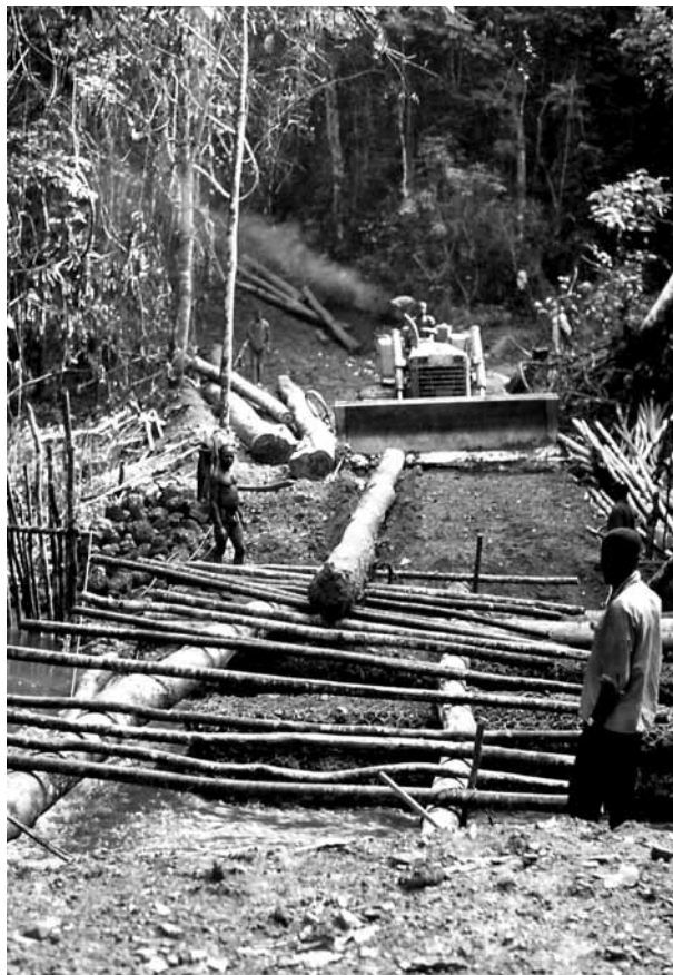
Photo 9. Construction d'un pont sur la rivière Lébombi en 1969 (cliché Gérard Delorme).
