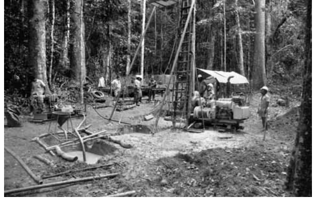
Photo 11 : Chantier de sondage au nord de Bélinga en 1980 (cliché Gérard Delorme).
