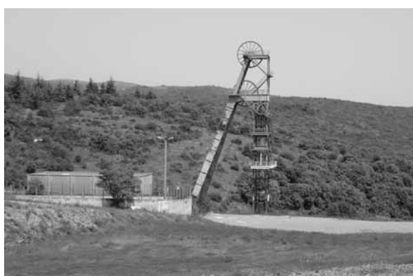
Photo 2b. Le puits Castan aujourd'hui (cliché Gérard Sustrac).
