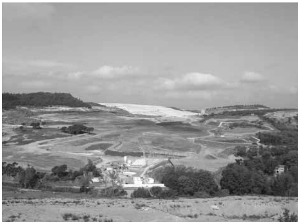
Photo 3. Vue générale du site de la Combe du Saut prise depuis l'Artus ; au premier plan, la station de traitement des eaux ; au fond, le stockage de Montredon (cliché ADEME).
