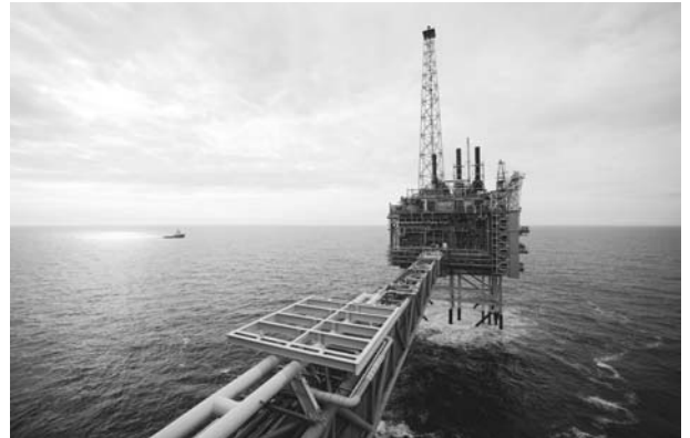
Photo 1. Les installations du site de Sleipner (Kjetil Alsvik Statoil).
