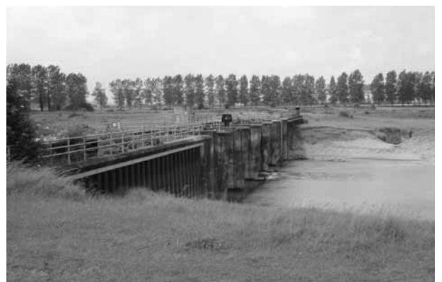
Photo 5. L'ancien barrage de la Caserne sur le Couesnon (cliché Gérard Sustrac).
