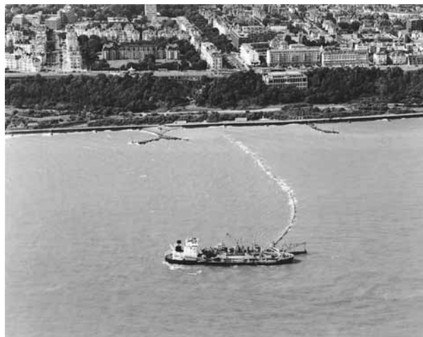
Photo 6. Rechargement de plage (cliché CEMEX UK Marine).
