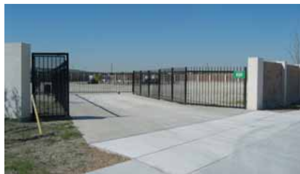
Photo 3. Installation de production conçue pour ne pas dépasser la hauteur du mur d'enceinte, lui-même identique aux murs des habitations avoisinantes, Fort Worth - Texas (Source : Total).
