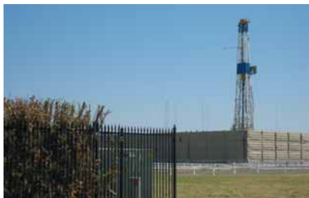
Photo 2. Appareil de forage et mur anti-bruit à proximité d'un jardin, Fort Worth - Texas (Source : Total).
