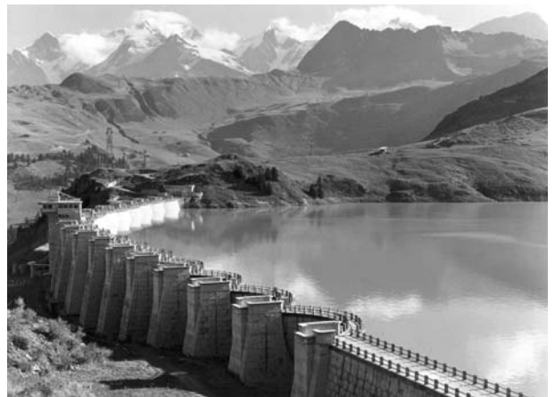
Photo 3. Barrage multivoûte de la Girotte sur le Dorinet, 73 (cliché EDF).
