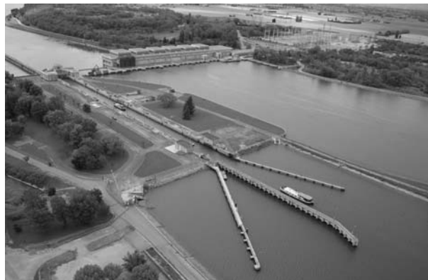
Photo 7. Ecluse de Bollène amont, sur le Rhône (cliché CNR).
