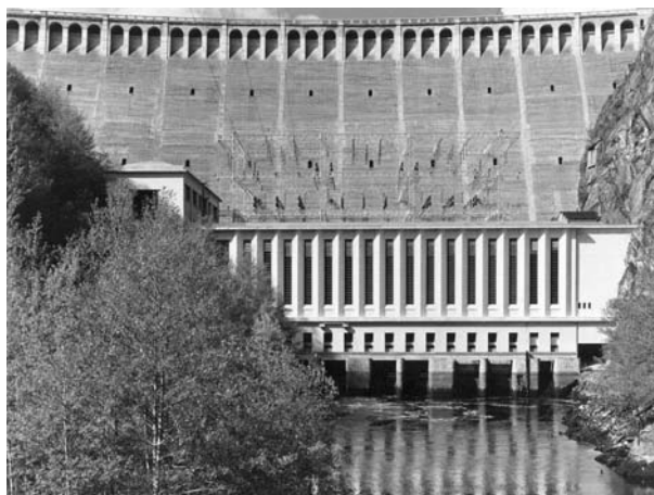
Photo 1. Barrage de Sarrans sur la Truyère, 12 (cliché EDF).
