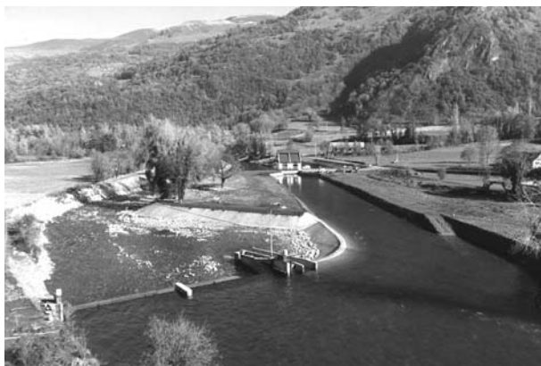
Photo 1. Vue d'ensemble d'un site de microcentrale : centrale de basse chute des Couscouillets à Villelongues, 65 (droits réservés).
