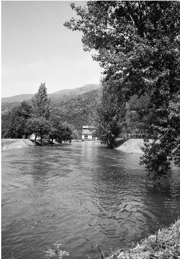
Photo 3. Canal d'aménée de la centrale des Couscouillets à Villelongues, 65 (droits réservés).
