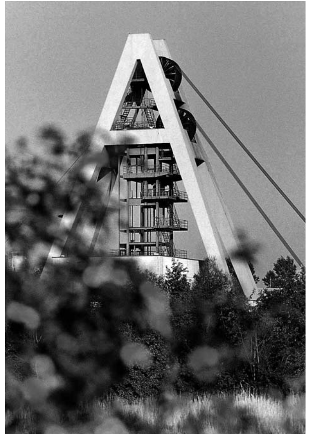
Photo 1. Puits Auguste-Victoria à Blumenthal, Allemagne (cliché Deutsche Steinkohle AG, DSK).
