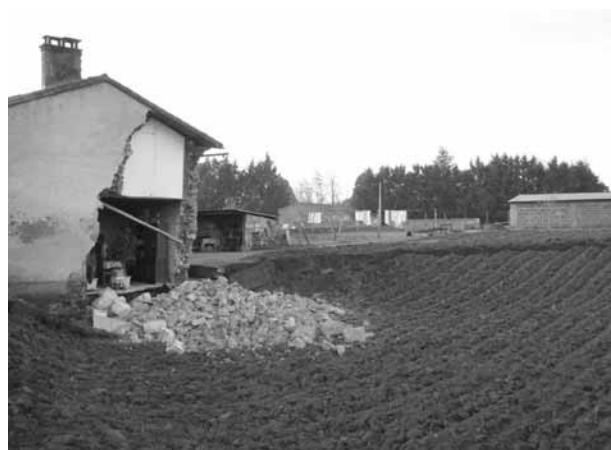
Photo 1. Bord sud-ouest de l'effondrement. Pignon éboulé d'une habitation (cliché : Bureau des Carrières Souterraines du CG33).
